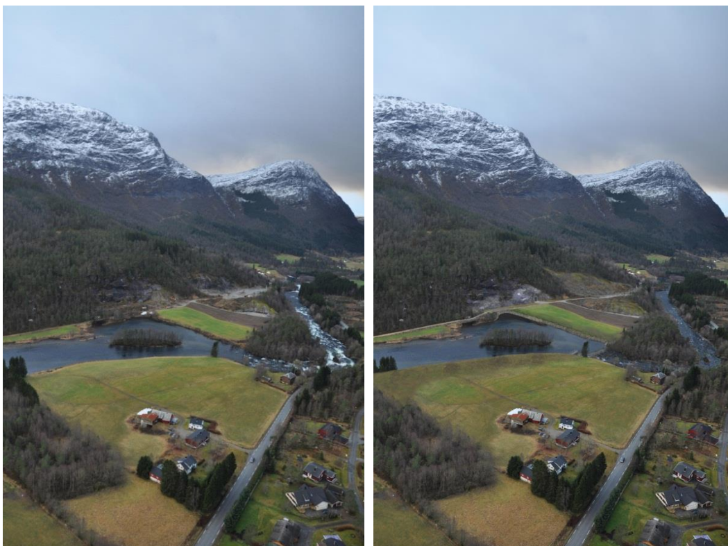
Figur 3. Inntaksområdet før (venstre) og etter (høyre) utbygging.
