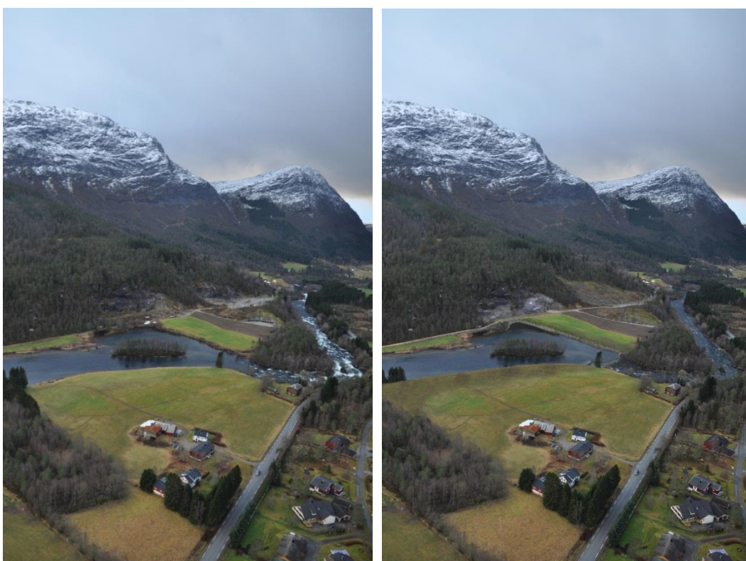
Figur 2-2. Inntaksområdet før (venstre) og etter (høyre) utbygging.
