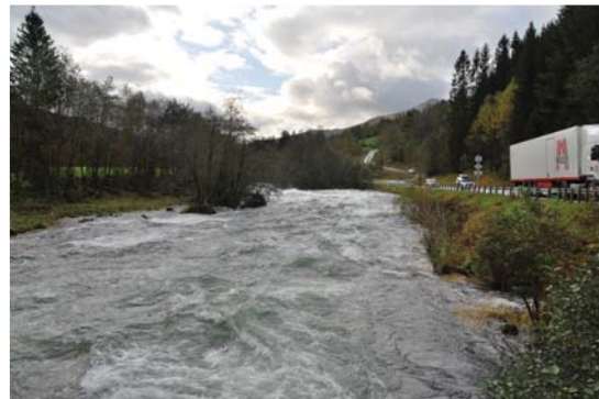
Nedstrøms gamle Kvamsbrua
