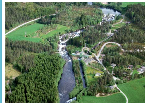
Stakaldefossen Kraftverk og koblingsanlegg for 22,66 og 132 kV .
